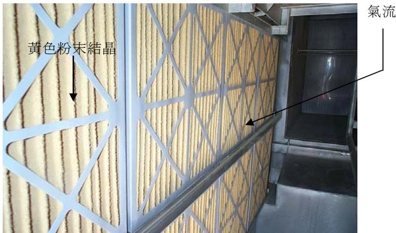
圖 3 A 廠 VOCs 濃縮轉輪焚化系統之前過濾器
